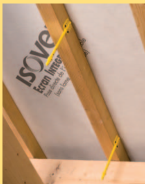
Fixation des suspentes Intégra 2
