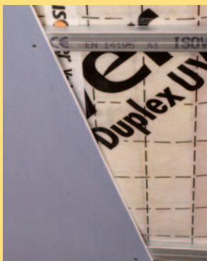
Pose du parement
