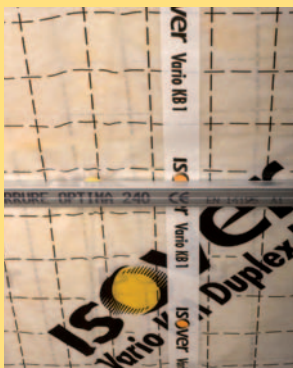
Mise en place des fourrures métalliques
